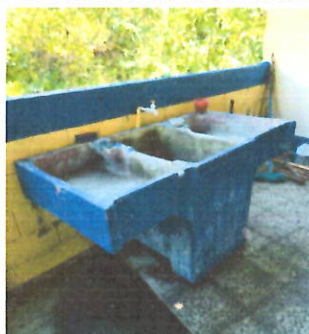
Foto 3: REPARACIÓN O SUSTITUCIÓN DE ÁREA DE COCINA
