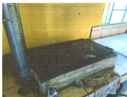
Foto 6: REPARACIÓN O SUSTITUCIÓN DE ÁREA DE COCINA
