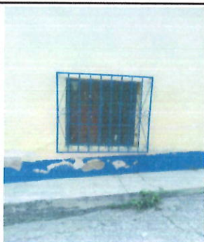
Foto 9: Sustrución de ventanas; sistema de apertura: corredizas, perfiles color blanco estandar, material del marco: PVC, material de la ventana: vidrio, sellado perimetral. Aula 1
