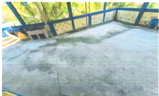
Foto 1: LOSA DE PATIO
