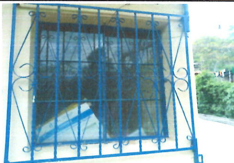
Foto 12: ventanas: sustrución de ventas; sistema de apertura: corredizas, perfiles color blanco estandar, material del marco: PVC Material de la ventana: vidrio, sellador perimetral. Bodega
