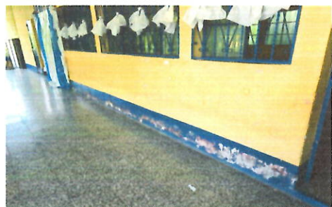
Foto 5: PINTURA EN MUROS INTERIOR Y EXTERIOR
