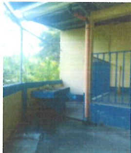
Foto7: Canales y bajadas de agua pluvial. Sustrución de bajadas para evacuación de aguas pluviales anclada por medio de abrazaderas y tornillos.
