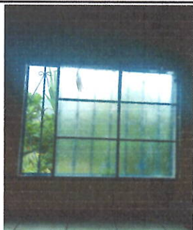
Foto 11: Ventanas: sustrución de ventanas; sistema de apertura: corredizas, perfiles color blanco estandar, material del marco: PVC Material de la ventana: vidrio, sellado perimetral. Cocina
